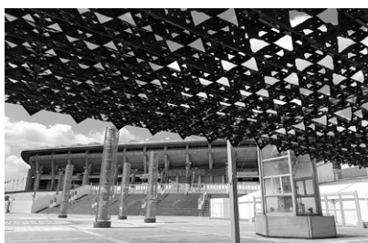
←横浜国際総合競技場東ゲート前広場のフラクタル日除け
