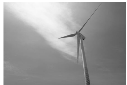
→横浜市風力発電所(ハマウイング)
